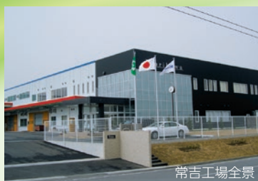
常吉工場全景
