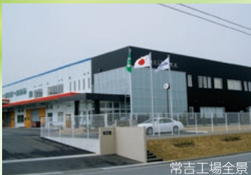
常吉工場全景
